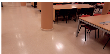
Suelo antes de la reforma.
