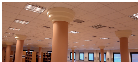
Techos e iluminación antes de la reforma.
