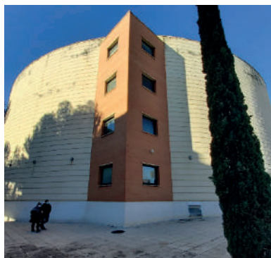
Fachada antes de la reforma.
